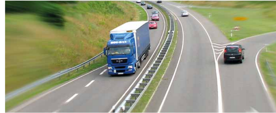
Seit mehreren Jahren entsteht unmittelbar westlich der Oder die Oder-Lausitz-Straße als großräumige Nord-Süd-Verkehrsverbindung. Die Trasse des Gesamtausbaus der Oder-Lausitz-Straße verläuft von der Autobahn A11/A20 im Bereich südlich von Prenzlau über Schwedt, Bad Freienwalde, Frankfurt (Oder), Eisenhüttenstadt und Cottbus als großräumige Verbindung bis zur Autobahn A13.
