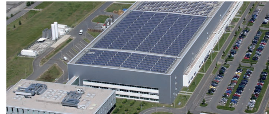
Mit den hocheffizienten Produktionslinien kann in Frankfurt (Oder) kostengünstig produziert werden. Schon jetzt liegen die Produktionskosten am Standort unter dem geltenden Solarmodulmindestpreis von 57 Cent pro Watt für Importe aus China.
